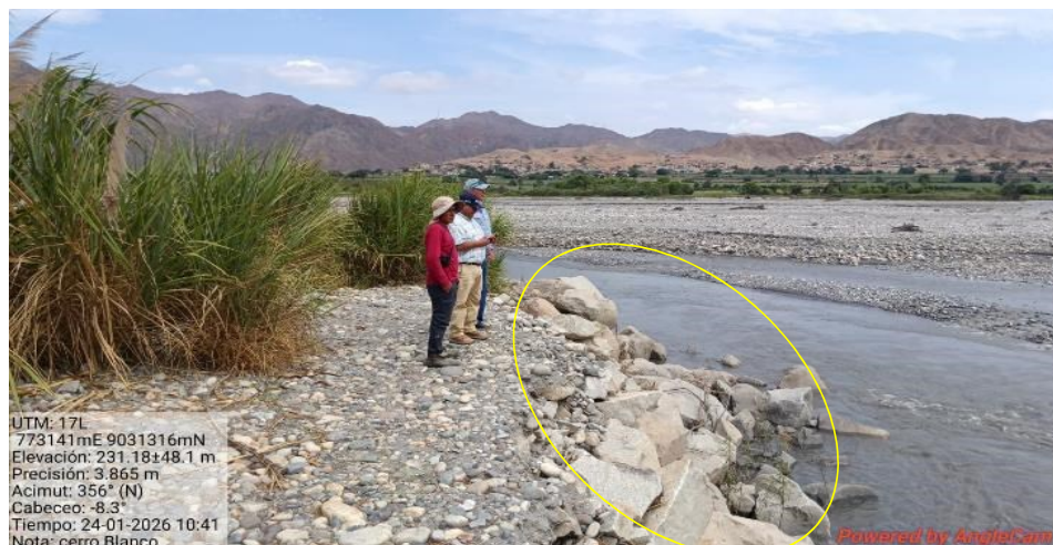
FIGURA N°01: TRAMO CRÍTICO EN EL RÍO SANTA, EROSION DEL DIQUE DEL MARGEN IZQUIERDO Y AFECTACION DE AREAS AGICOLAS , EN EL SECTOR CERRO BLANCO I, DISTRITO DE CHIMBOTE, PROVINCIA DE SANTA - ANCASH.
