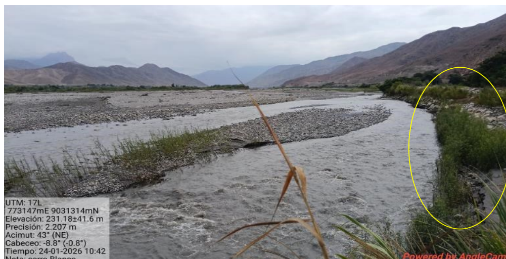
FIGURA N°03: DIQUE EN LA MARGEN IZQUIERDA EROSIONADO PROPENSO A DESBORDE Y AFECTAR AREAS DE CULTIVOS Y POBLACION DEL SECTOR.
